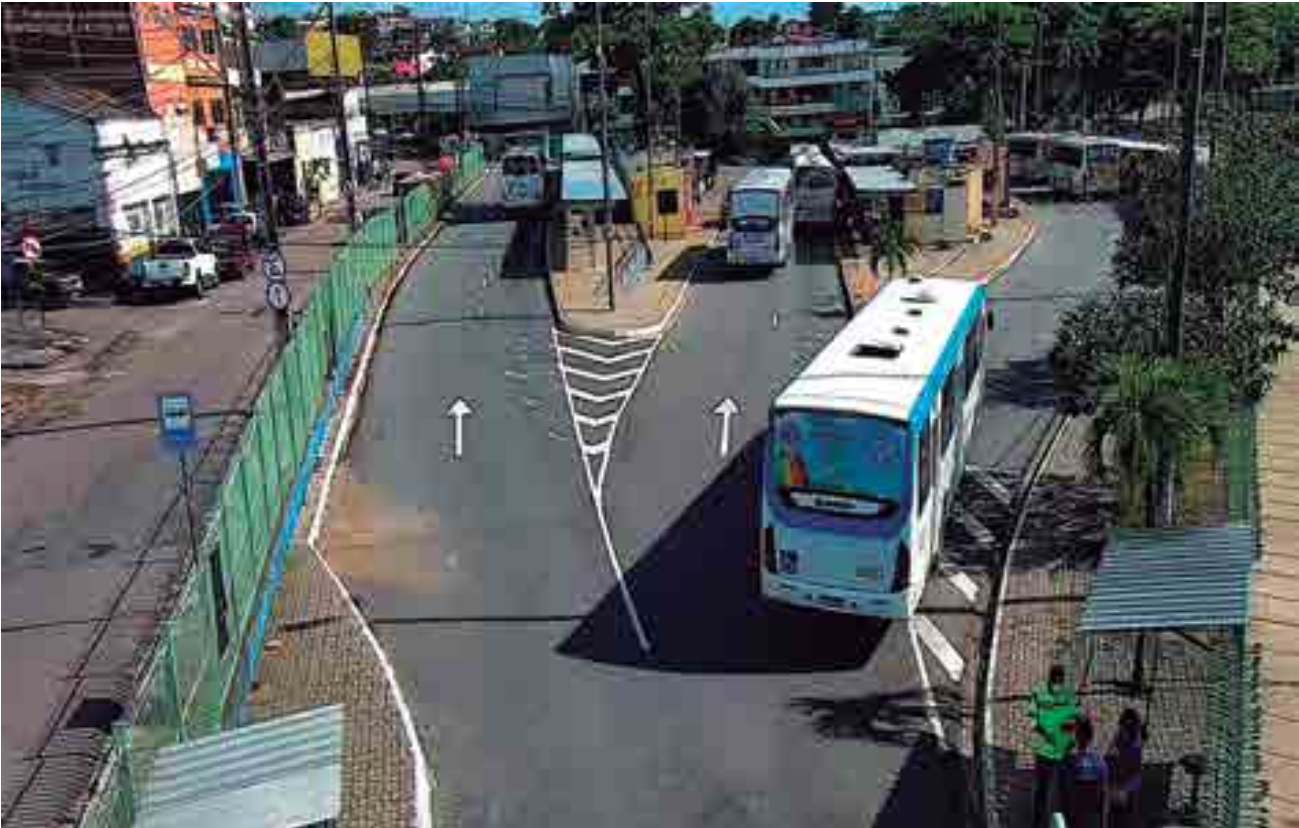
A plataforma C do Terminal de Integração do Varadouro voltou à operacionalidade após a conclusão da obra de recuperação da rede de drenagem e da pavimentação
